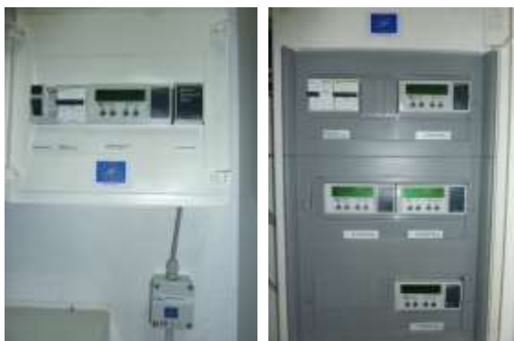
Figura 2. (Sistema de monitorización de consumos energéticos de infraestructura TIC).
